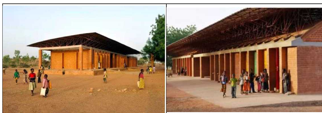
校舍建築採用當地的粘土磚塊，有保溫作用，錫質大屋頂利於排水和通風
