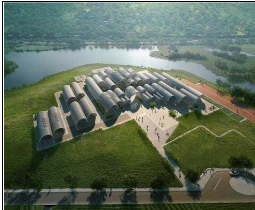
學校建築最大特點是一系列混凝土桶和拋物線拱頂
