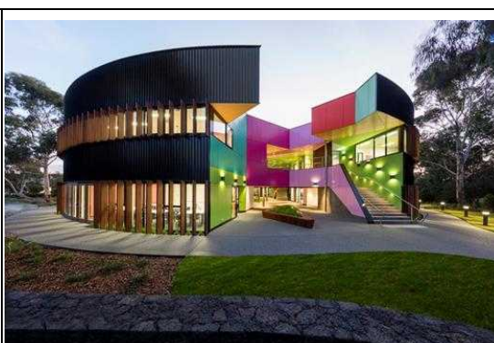
校舍二層樓內裝色彩豐富
